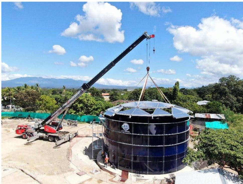
**Pie foto:** Proceso de instalación del domo del nuevo tanque "Santa Ana", en Liberia. FOTO: UNOPS.
